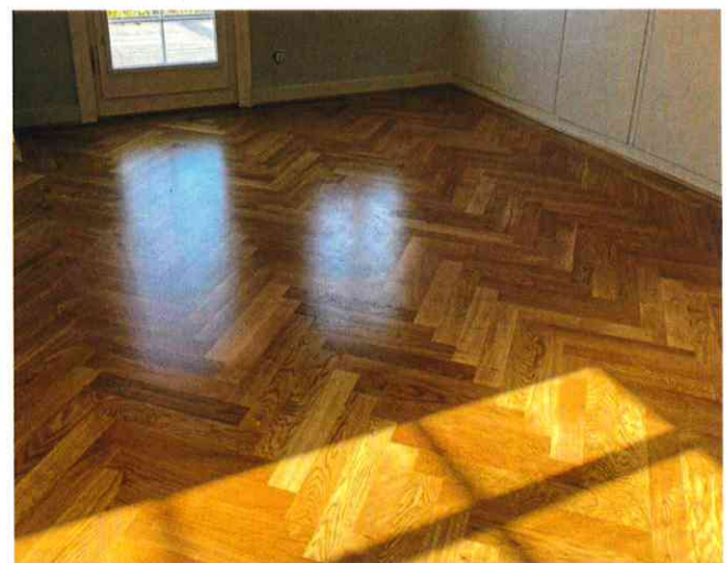
Das Siegerprojekt: Die Neuverlegung von 100 m 2 Eichenparkett in einer Villa überzeugte die Pallmann-Jury.
